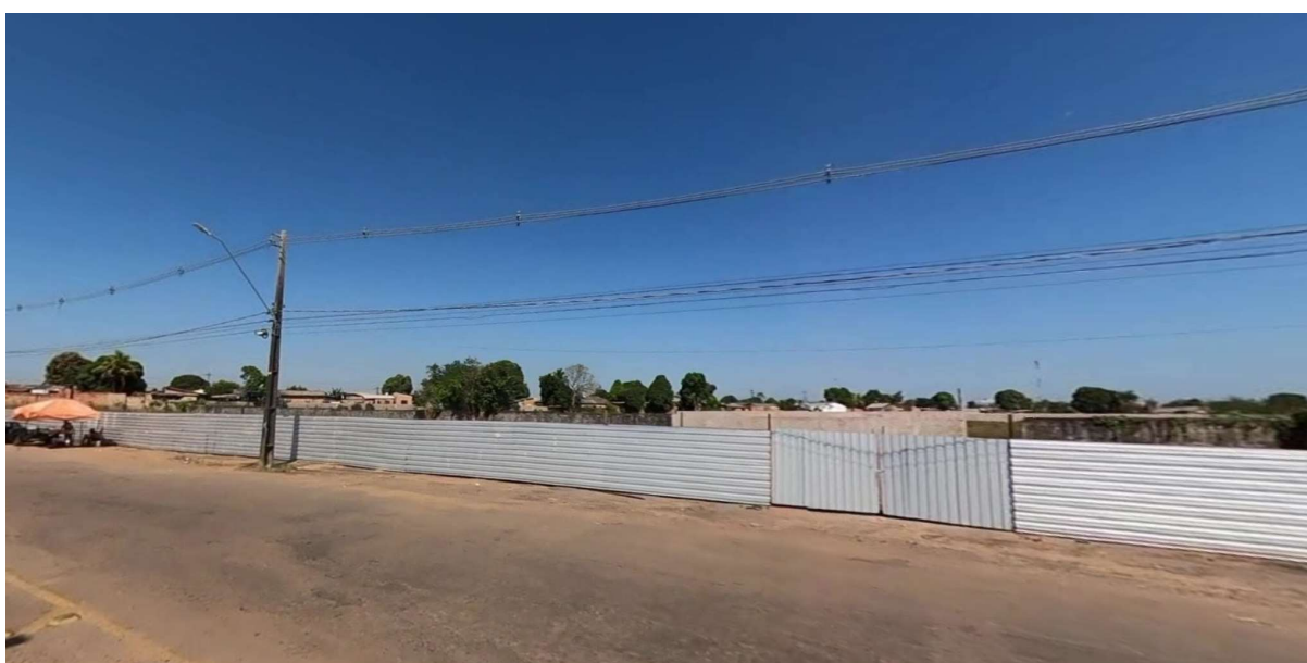
Figura 43: Local onde serão construídos os acessos e saídas do empreendimento
