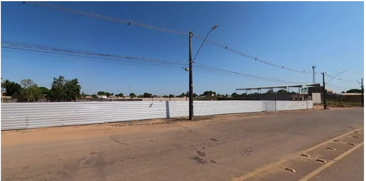
Figura 41: Local onde serão construídos os acessos e saídas do empreendimento
