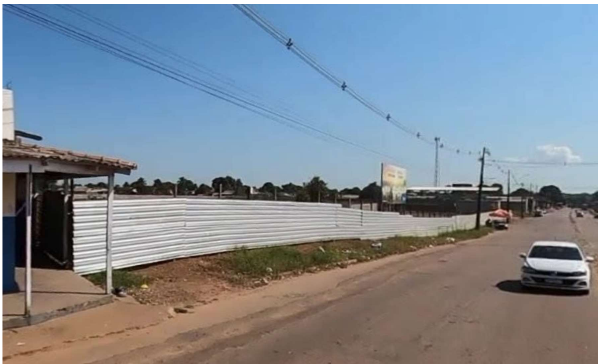
Figura 42: Local onde serão construídos os acessos e saídas do empreendimento
