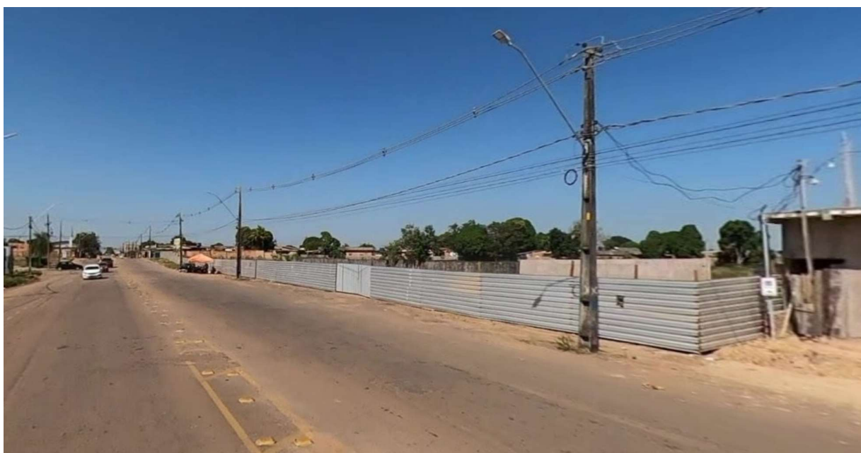
Figura 45: Local onde serão construídos os acessos e saídas do empreendimento
